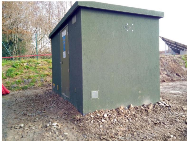
Figure 5 : Photo d'un poste de transformation d'une centrale photovoltaïque réalisée par IEL
